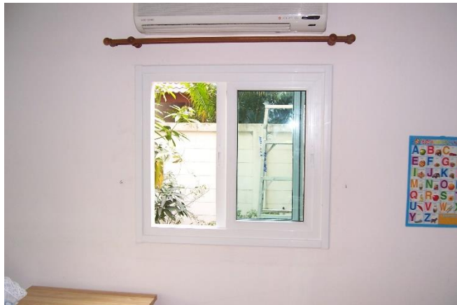
รูปลักษณะบ้านช่องแสงใหม่ หลังการติดตั้ง
